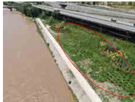
两铁桥处植被生长情况
